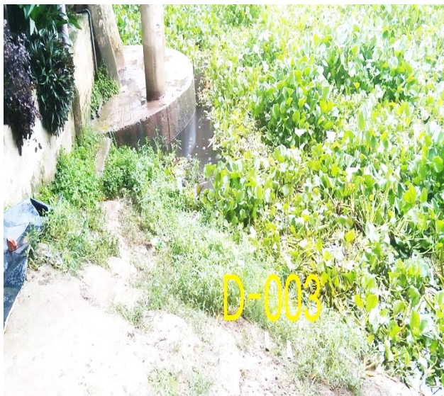
Photo , Haziganj- Drain -003
