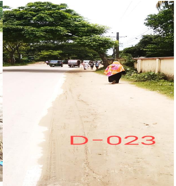
Photo , Haziganj- Drain -23
