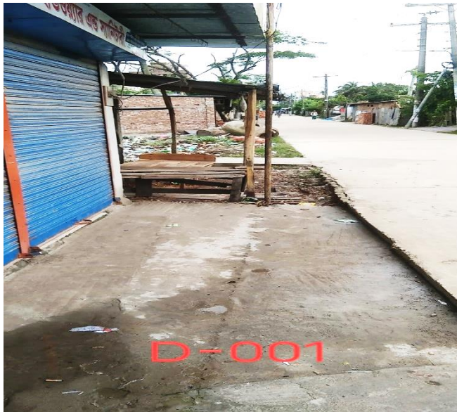
Photo , Haziganj- Drain-01
