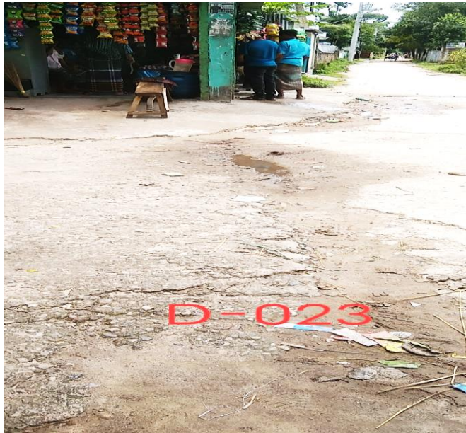
Photo , Haziganj- Drain -23
